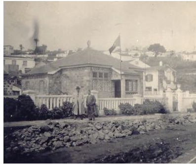
Edifício do Comando
